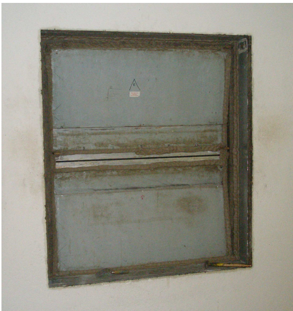
Bild 3 Foto des eingebauten Elementes (erstellt vom ift Schallschutzzentrum)
