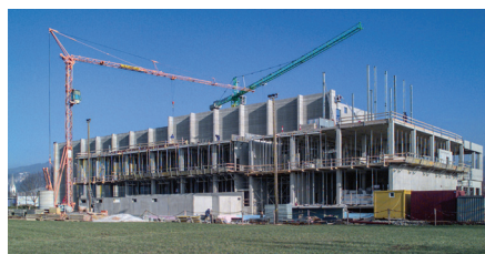
Vormontage von Ankerschienen erhöht die Effizienz und Sicherheit auf Baustellen.
