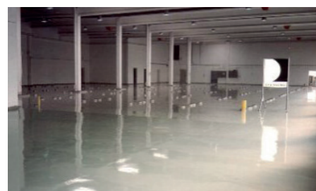
Beispiel einer WHG-Dichtfläche
